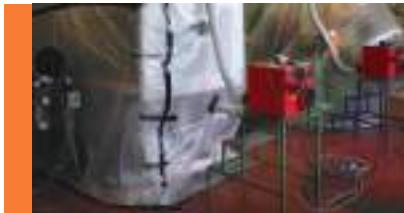
**Protezione della componentistica elettrico-elettronica:** installazione di una zona a umidità controllata realizzata tramite cocoon in polietilene e impiego di deumidificatori professionali.
